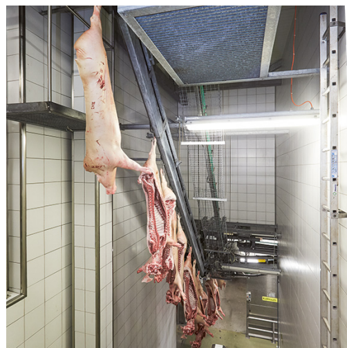
Figura 7: tubovia separata dalle vie di circolazione
