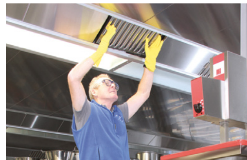
Image 6: procéder aux opérations de nettoyage avec l'équipement de protection correspondant
