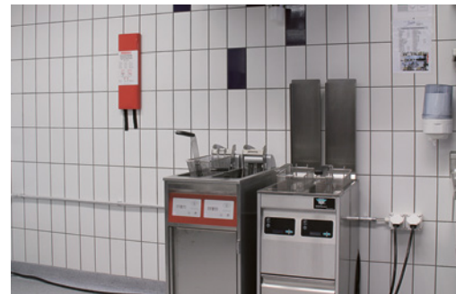
Image 5: mettre la couverture antifeu à disposition près de la friteuse
