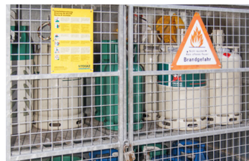
Image 8: bouteilles de gaz correctement stockées
